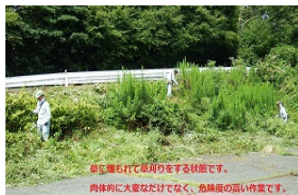
本日の定例会、どこかに秋を感じられる日ではありましたが、作業中はやはりまだまだ厳しい暑さでした。参加者は9名。ミーティングの後、さっそく第一現場の「ファミリーパーク南駐車場」へ移動。しばらく草刈りをしていなかったため、大変な草の量です。
