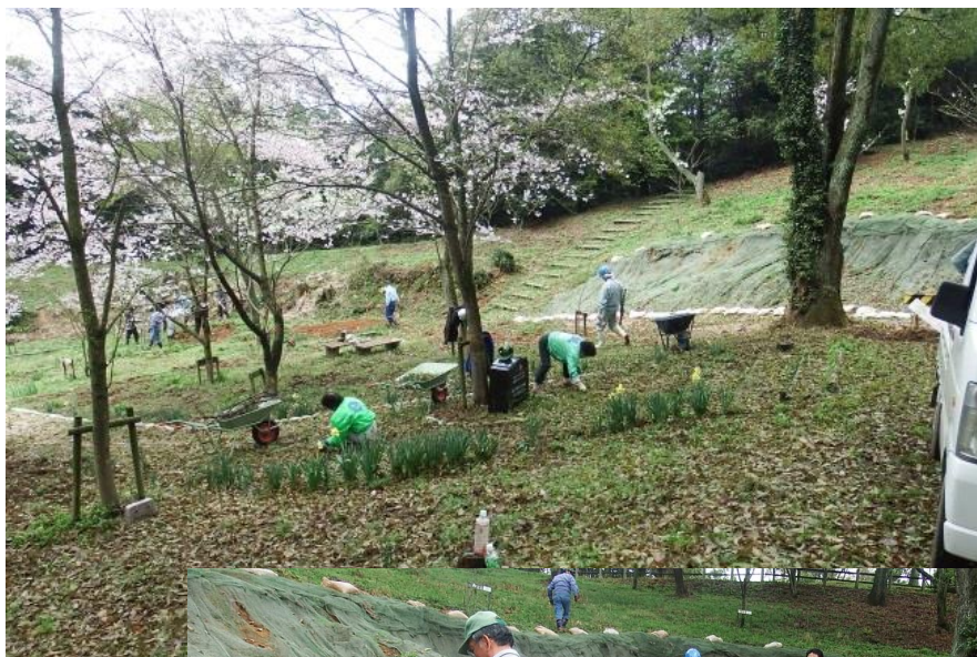
「仮復旧作業完了後」
